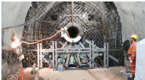
閉鎖試験環境の建設状況
